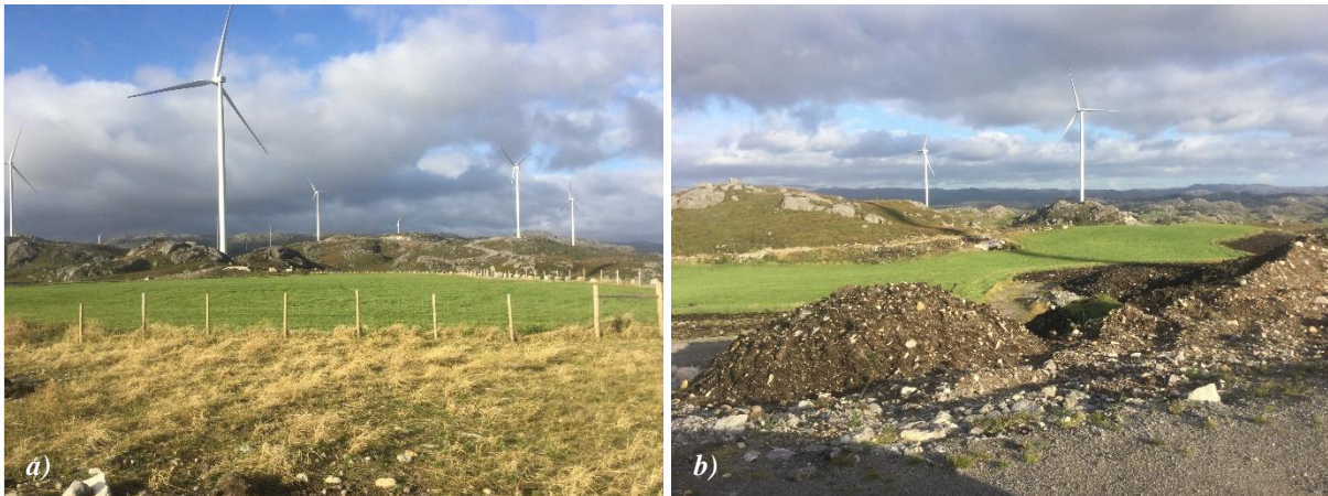
Figur 6.1. Arealer som er gjort om til dyrka mark etter at vindkraftverket er etablert og ferdigstilt. a) Dyrka mark som er etablert der det var en lagringsplass under anleggsfasen til vindkraftverket. b) Dyrka mark som er etablert i utmark, trolig mest myr.
